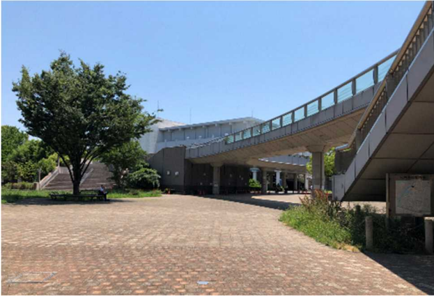
①ペDESTリアンデッキ (事業対象地北西角から望む)
