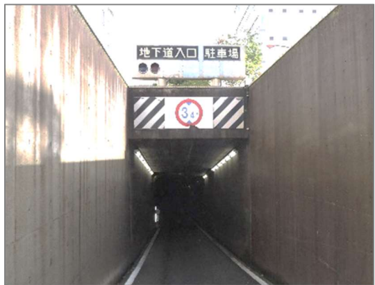
藤沢駅北側車地下道
