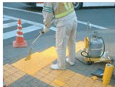
輝度比対応型視覚障がい者誘導用ブロック インターロッキング等輝度比を確保することが困難な場合に有効 ※株式会社マツオコーポレーション
