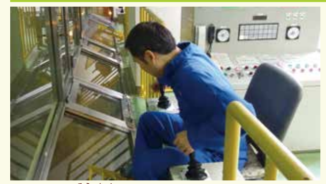
クレーン操作室
