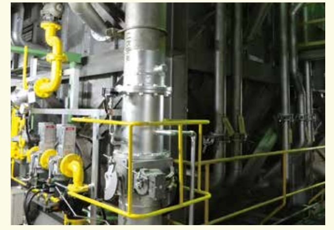
焼却炉 熱せられた砂を使ってごみを燃やしています。
