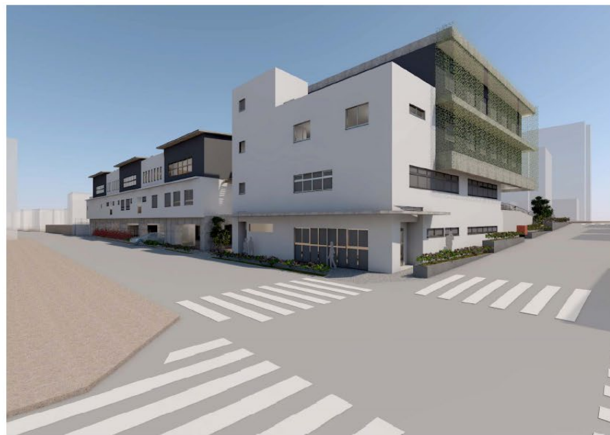
アイレベル・北西面
