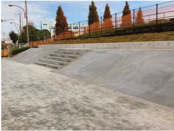
コンクリートバンクセクション
