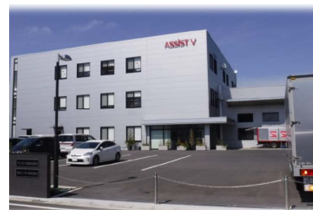
▲新産業の森北部地区 現況写真
