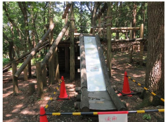
（修理中のアスレチック遊具）
